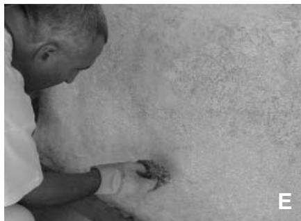
Fig. 12. Prospetto Nord (facciata su piazzetta Antonini): documentazione di alcune fasi dell'intervento. **A-B)** facciata (particolare) prima e dopo l'intervento; **C-D)** tinteggio a pennello; **E)** velatura eseguita con maltina molto fluida stesa a spugna nelle parti di intonaco che presentano una superficie molto usurata.
