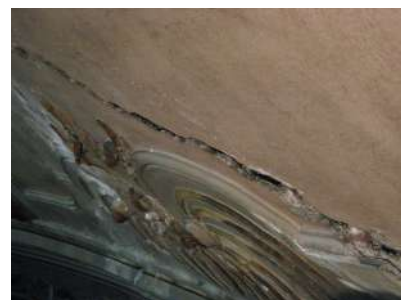
Fig. 17. La lesione provocata dal sisma nella cupola dell'aula vista dall'estradosso e sull'intradosso.
