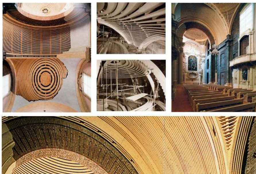
Fig. 19. Proposta progettuale per la realizzazione di un controsoffitto voltato, costituito da una successione di travi in legno lamellare.
