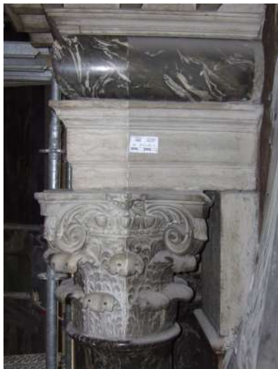
Fig. 6. Prove di pulitura delle superfici lapidee del presbiterio.
