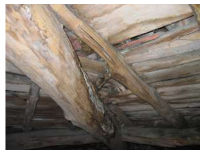
Fig. 16. Dettaglio del degrado dell'orditura lignea del tetto.
