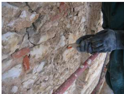
Fig. 27. Consolidamento di una lesione nella muratura a vista mediante percolazioni di malta.
