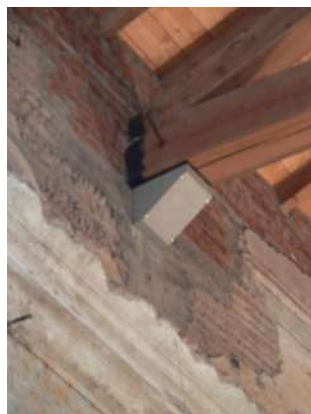
Fig. 33. Consolidamento dell'arco centrale e consolidamento degli appoggi delle capriate.
