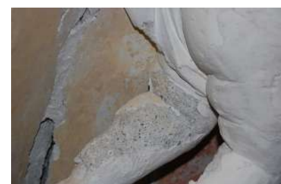
Fig. 17. Strati di finitura e di modellatura visibili nel degrado.
