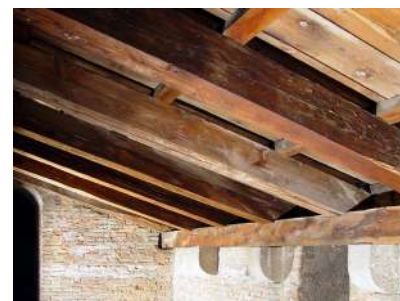
Fig. 4. L’orditura lignea di un tetto rettangolare del deambulatorio.
