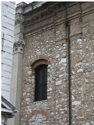
Fig. 26. La parete laterale in muratura in pietrame a vista con lesene al grezzo ed elementi specialistici in laterizio (foto N. Badan).
