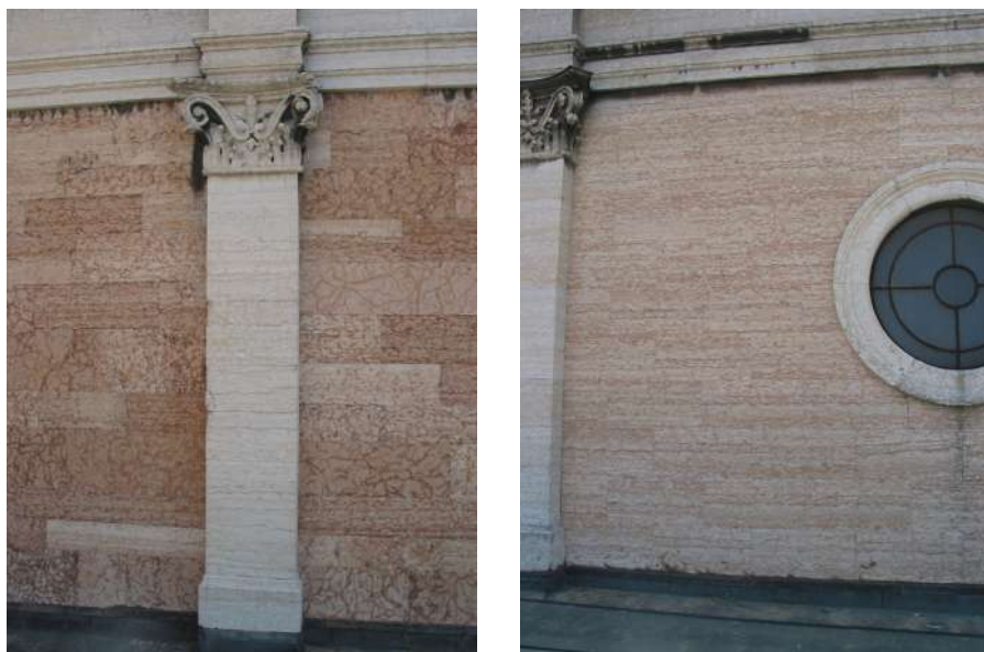
Fig. 16. Prospetto settentrionale, sopraelevazione: paramenti realizzati con conci di recupero provenienti dalla facciata e con conci nuovi.
