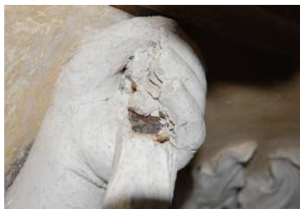
Fig. 15. Ferri quadri ribattuti e nastri plissettati a battitura; armatura a sostegno dell'ornato architettonico; armatura in ferro battuto sagomato degli elementi fitomorfi delle cornici.
