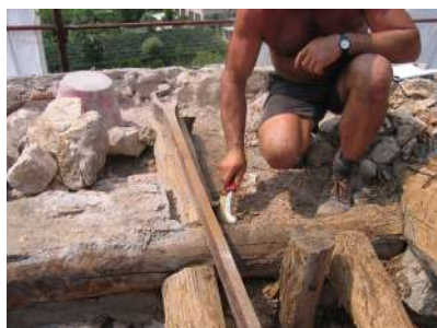
Fig. 9. La testa di uno dei tiranti estradosali della cupola del presbiterio in fase di restauro.
