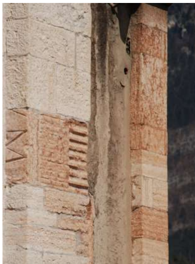
Fig. 5. Reimpieghi di elementi romani nelle strutture trecentesche.
