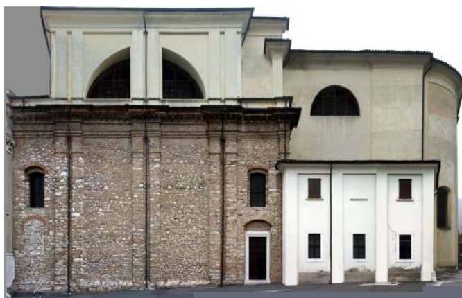
Fig. 3. Fronti laterali con muratura parzialmente a vista (stato di fatto e simulazione di progetto - elaborati grafici: arch. N. Badan).
