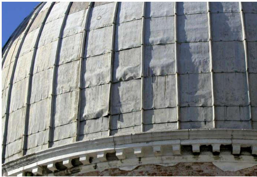
Fig. 12. a) frattura di una lastra plumbea; b) lacerazioni provocatesi su una lastra in corrispondenza delle chiodature; c) scivolamento delle lastre con perdita di contatto e scoprimento del tavolato sottostante; d) cupola presbiteriale: deformazioni del bordo inferiore delle lastre tratteneute solo dai ganci in rame, sintomo di prossimo collasso.
