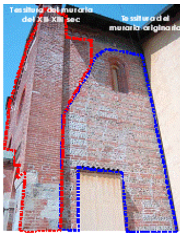
Fig. 2. Discontinuità muraria dovuta all'ammorsamento tra paramento originario e paramento dei secoli XII e XIII.
