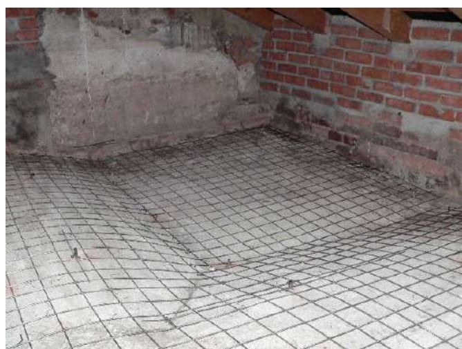
Fig. 32. Consolidamento delle volte.
