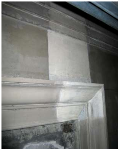
Fig. 10. Prove di pulitura dei marmorini del presbiterio (blu) e della navata (bianco).
