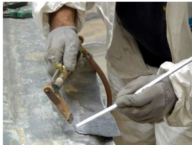
Fig. 16. Cupola maggiore: intervento di ricostruzione di un tratto di costolatura risultata marcescente.
