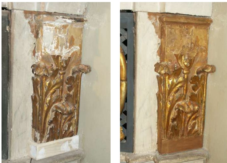
Fig. 36. Integrazione parziale degli elementi mancanti della bussola in legno decorato a finto marmo.
