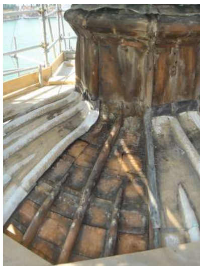
Fig. 10. Il sistema di montaggio delle lastre plumbee.
