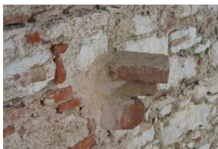
Fig. 30. Dettaglio della sostituzione di un rassetto di malta cementizia.
