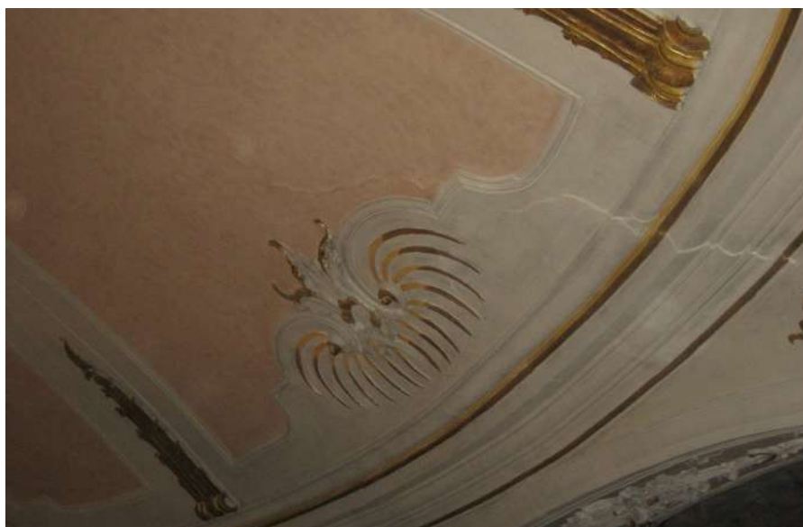
Fig. 39. La lesione della cupola è stata riparata conservando la percepibilità della dislocazione dei cigli, a testimonianza del dissesto pregresso.
