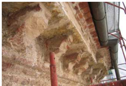
Fig. 29. Fasi del restauro del cornicione in cotto.
