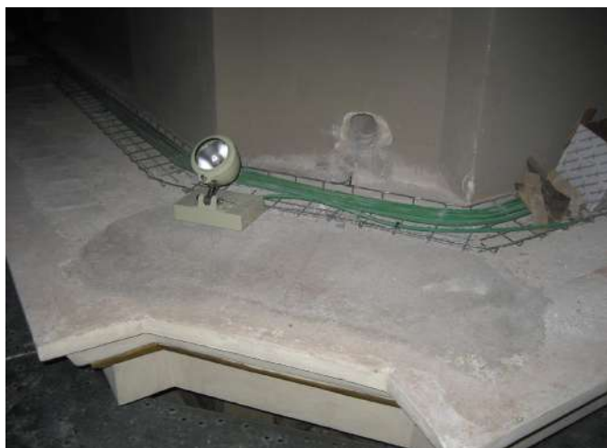
Fig. 38. Dettagli dell'intervento di adeguamento dell'impianto elettrico, con canalizzazioni a vista e utilizzo di cavi tessili.
