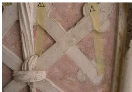
Fig. 13. Decorazione della paraste. Nelle cadute della plastica è visibile il disegno preparatorio a carbone ed a graffite, i fori dei tasselli di sostegno delle integrazioni di restauro a sua volta perduti.
