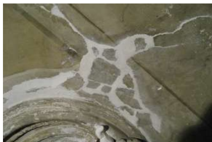
Fig. 35. Intervento di integrazione con rimontaggio dei frammenti di intonaco e stucco decorato nel catino absidale.
