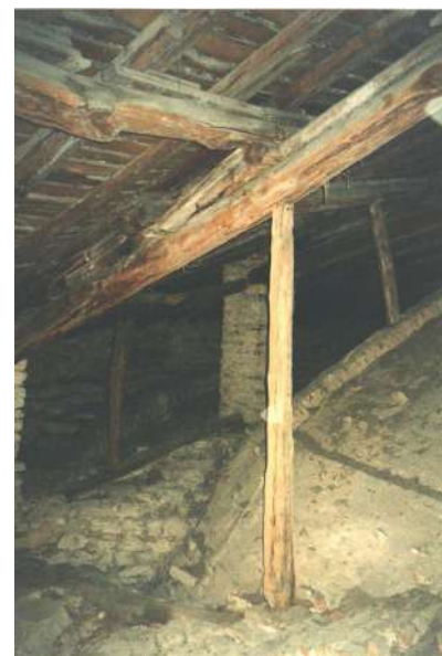
Fig. 6. Scorcio del sottotetto con dettaglio dell'estradosso della cupola dell'aula e del sistema di copertura (foto ing. S. Tonoli).
