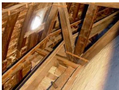
Fig. 7. Un tratto della macchina lignea ottocentesca con i telai interni e le centine di irrigidimento.
